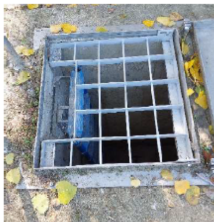
Fig. 5: met uitsparing voor valbeveiligingspaal
