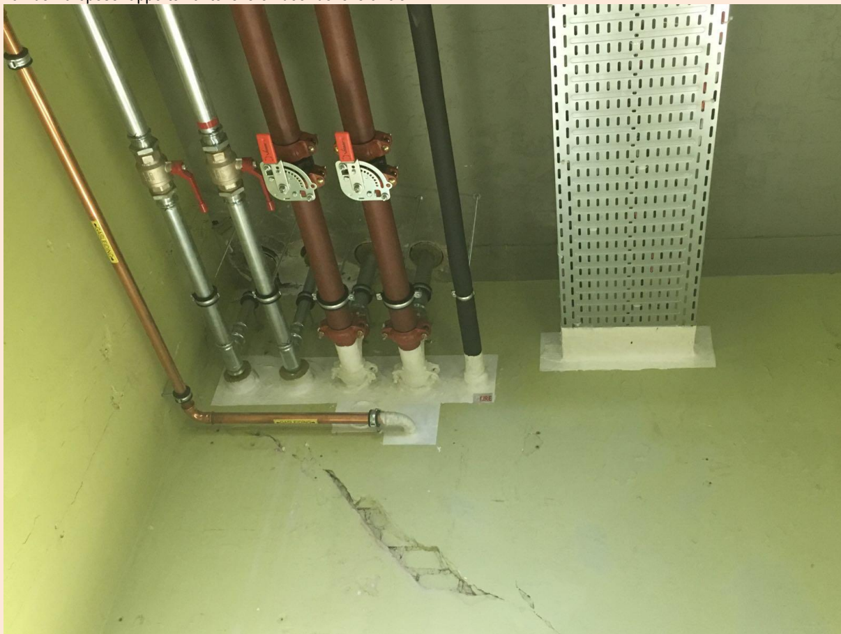
Foto ter inlichting uitvoering brandwerende dichtingen.
