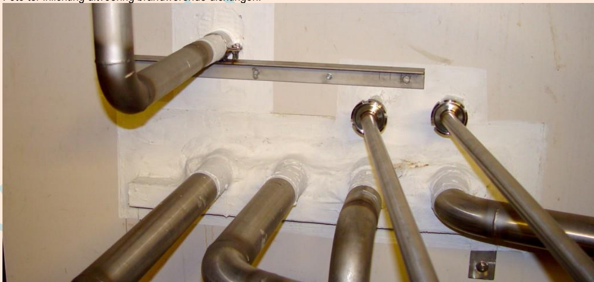
Foto ter inlichting uitvoering brandwerende dichtingen.
